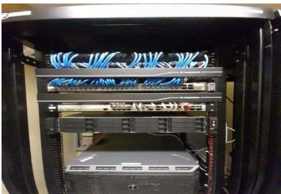
Imagem 105 - Servidor Storage Instalado no Rack da Sala dos Servidores
